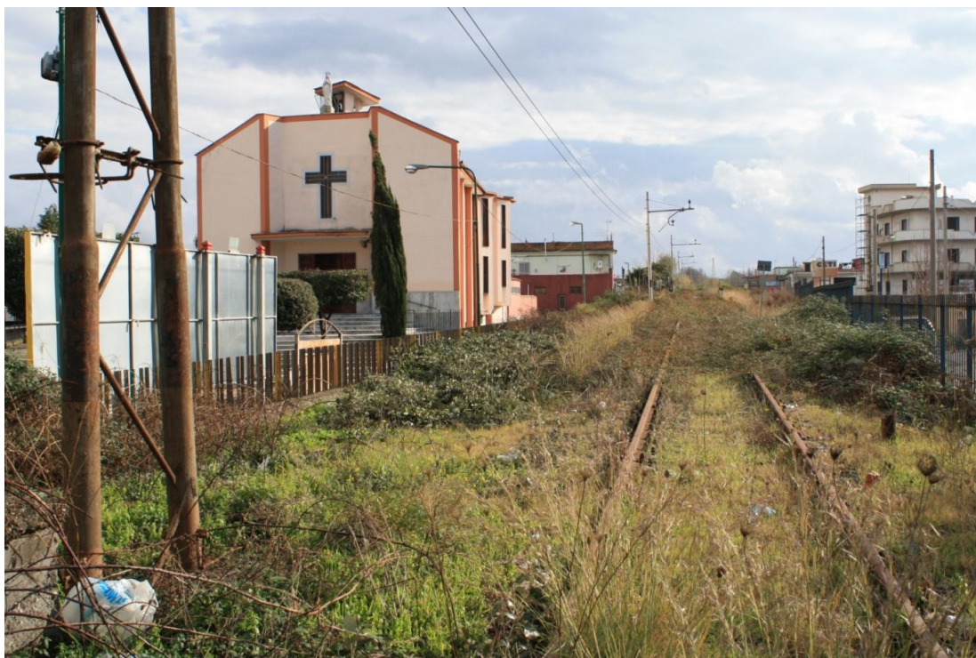
Rilevato ferroviario nel centro abitato in avanzato stato di degrado ed abbandono
