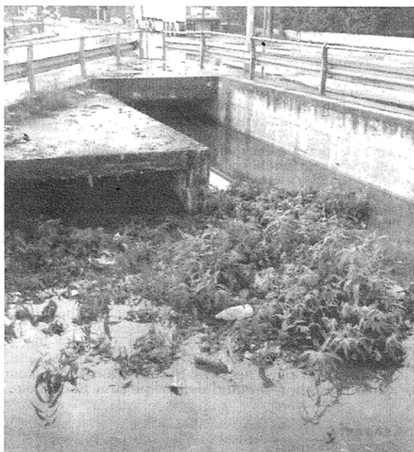
REGI LAGNI AL COLLASSO Incubo allagamenti in tutta l'area
